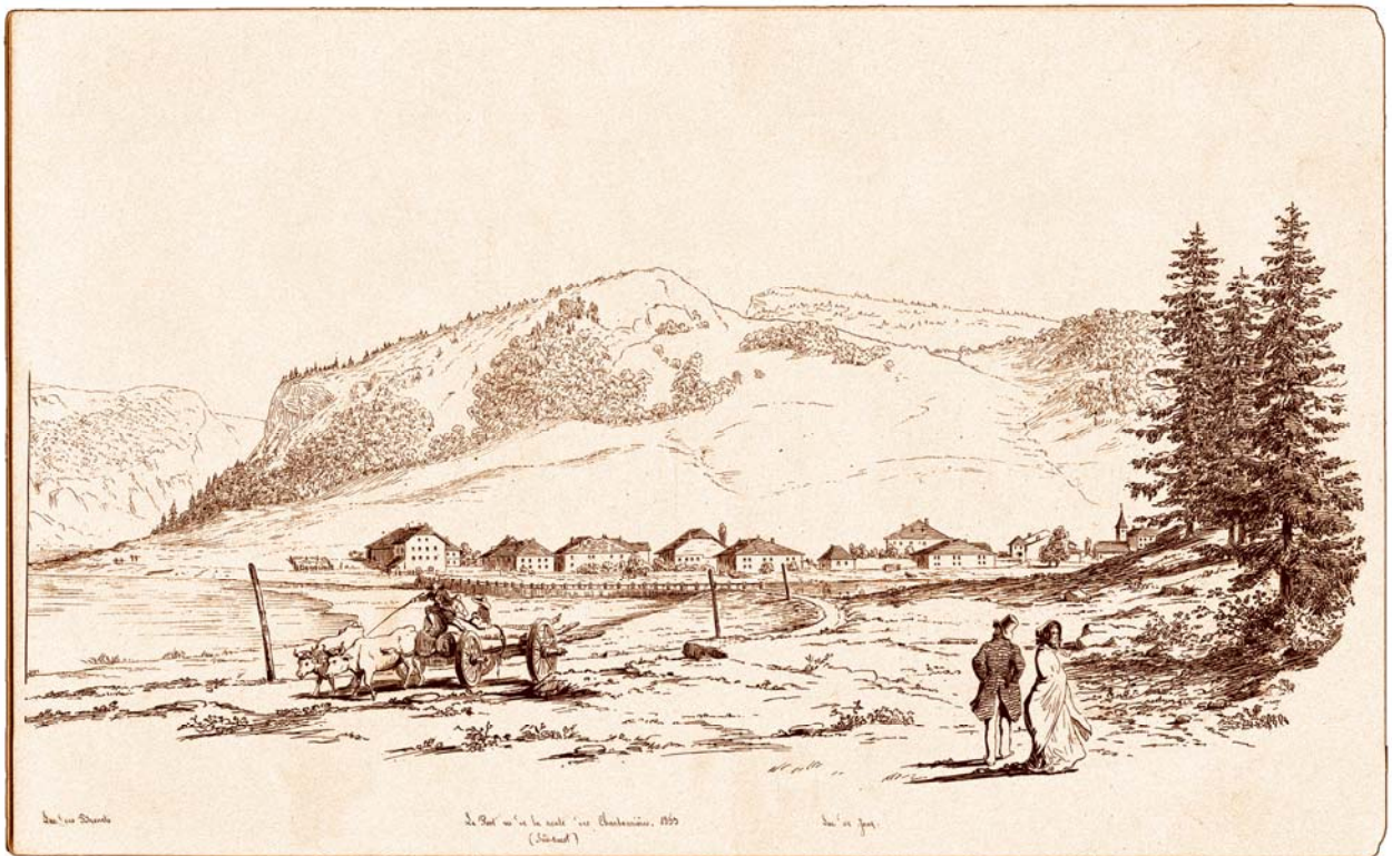
A proximité du Pont en 1855. Même type d'attelage conduit par deux bœufs. Le voiturier se rend peut-être à Bonport où il fera scier ses troncs. Installations industrielles tenues à l'époque par Armand Rochat, ancien boulanger du Pont.
